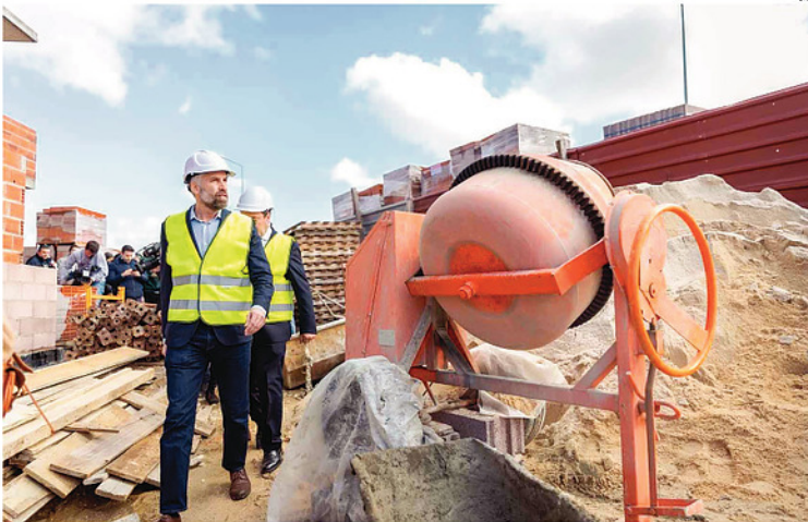
Pedro Nuno Santos visitou as obras de construção de novas casas em Anadia
