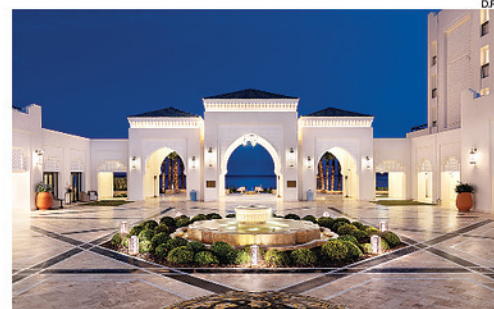
Empresa instalou portas de alta performance na unidade hoteleira
